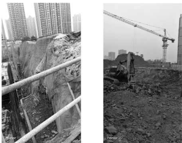
(a) 已完成岩质基坑情况 (顺向坡) (b) 正在开挖的岩质基坑情况 (逆向坡)
