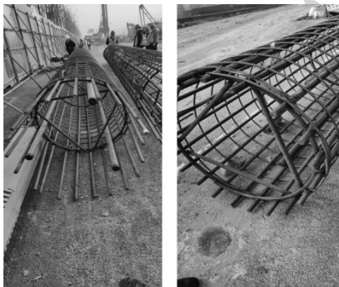
图 7.2.1 某工地声测管埋设实物
