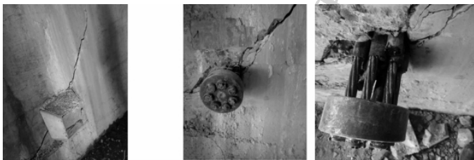
(a) 锚头混凝土剥开前外观质量
