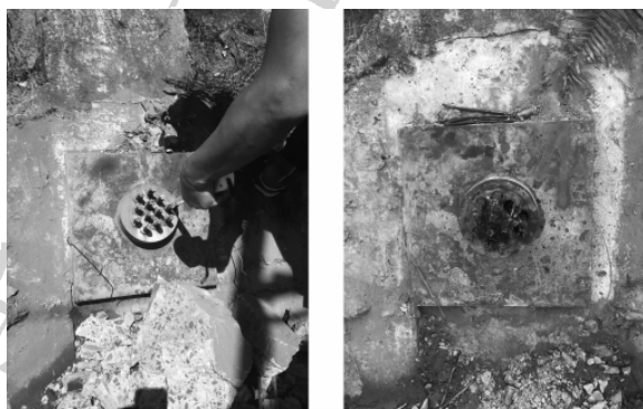
(a) 锚索外锚头检测情况
