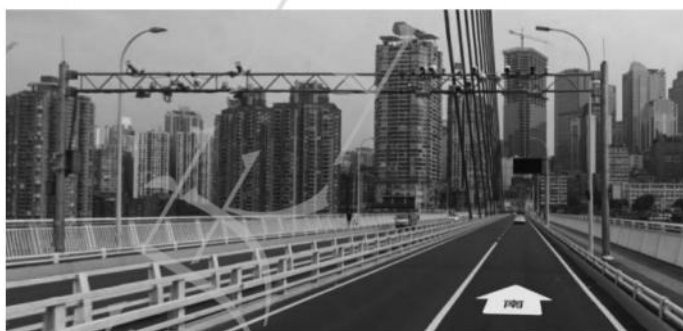
图 4.2.5 千厮门大桥中段设置的交通检测设备
